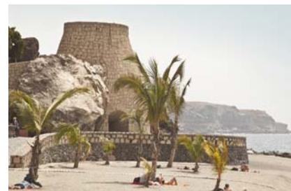
Este horno del siglo XIX, actualmente en desuso, fue empleado para la producción de cal, imprescindible en la construcción tradicional, a partir de la cocción de rocas calizas a una temperatura entre 900 y 1.200°C durante varios días.
