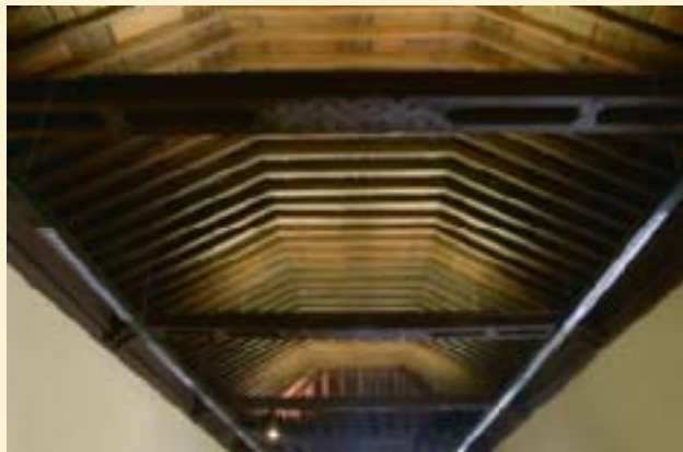
Techumbre del Salón Noble.
